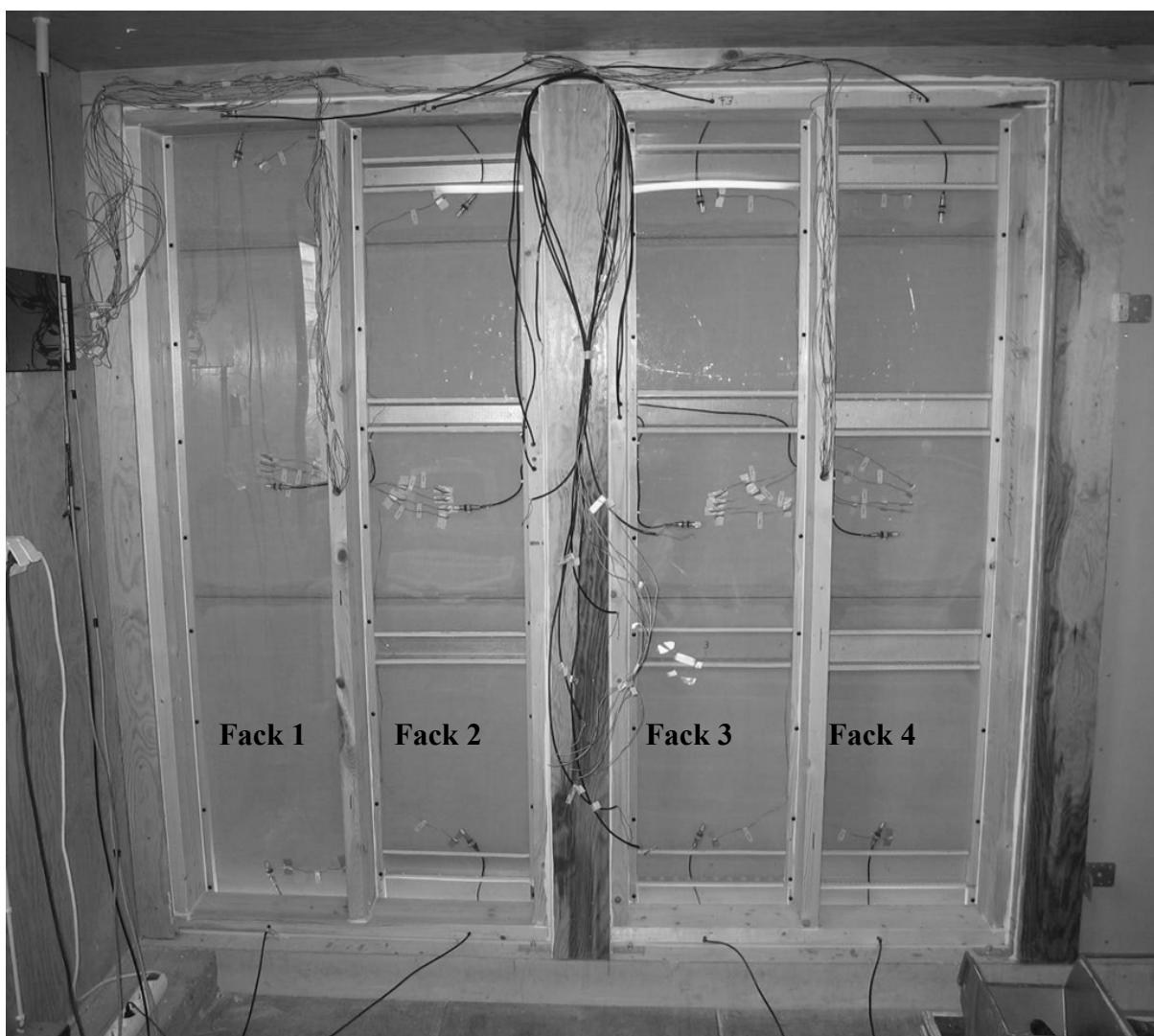
Figur 6-2 Experimentväggar med installerade givare i vy inifrån.
